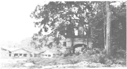
Kawasan Istana Bukit Tinggi mulai dibangun dengan projek perumahan.
